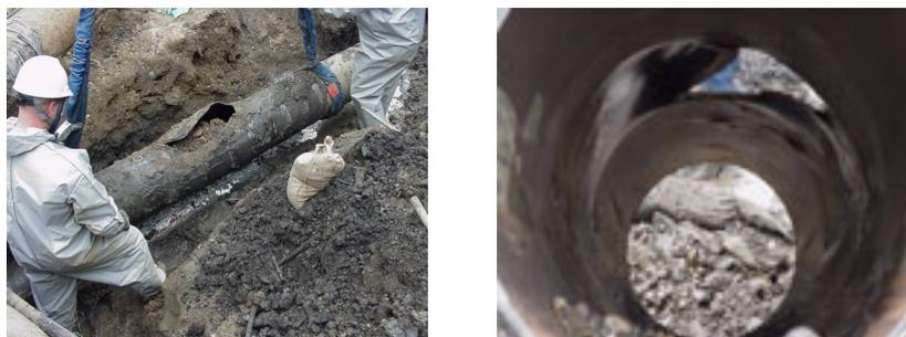
FIG. 1.2 – Pipeline endommagé.
