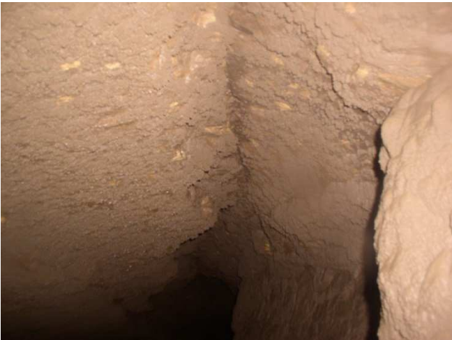
(15) Plafond de la galerie du Traveling
