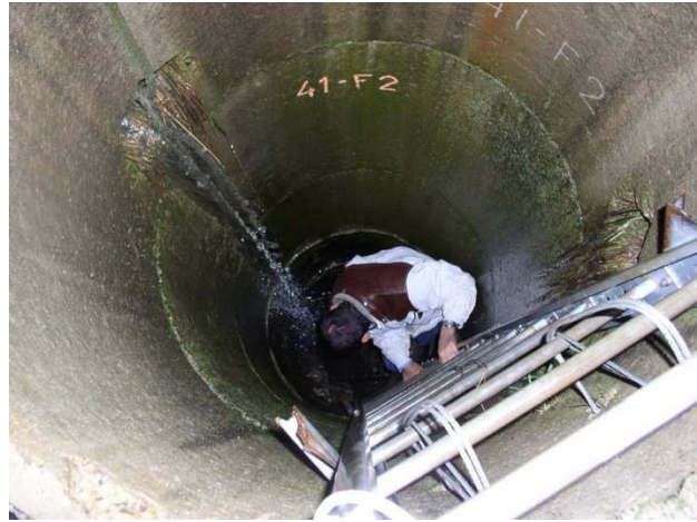
(2) Petite crue dans l'entrée
